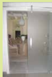
Brede schuifdeur voor rolstoel
