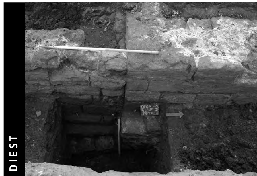
Detail van de ijzerzandstenen fundering in sleuf 2 (© Monument Vandekerckhove nv).
