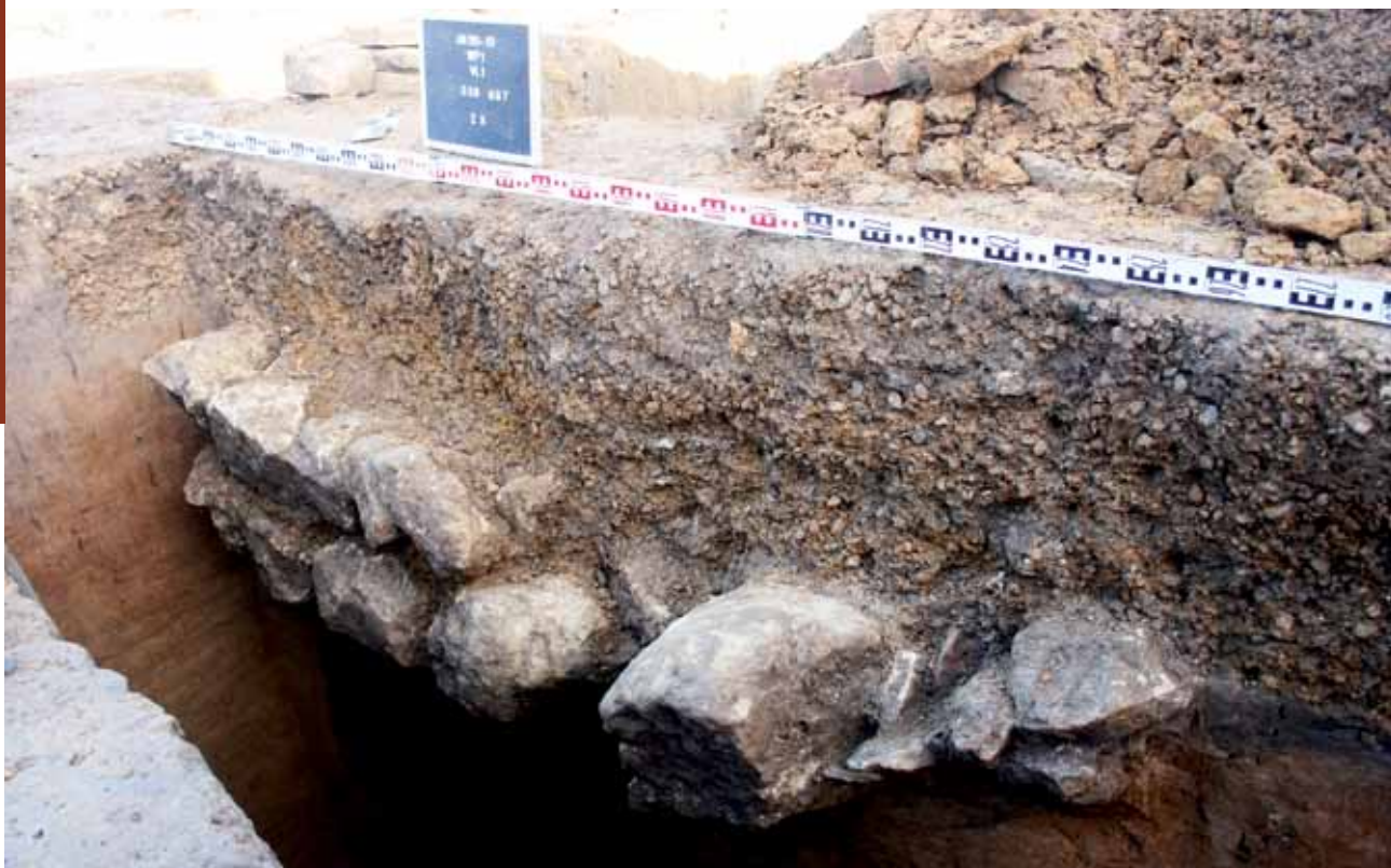
fig. 1 - Om stabiliteitsproblemen te vermijden werd het gebouw op de plaatsen van deze oudere kuilen merkkelijk dieper en sterker gefundeerd door middel van enorme blokken kalkzandsteen (© Kristine Magerman – K.U. Leuven).
